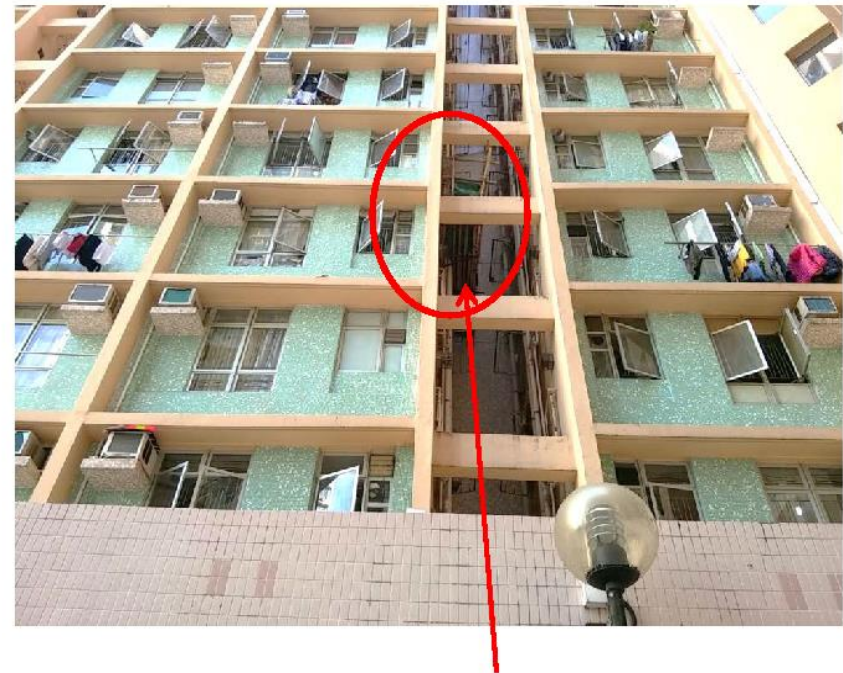
室外牆棚架及位置
