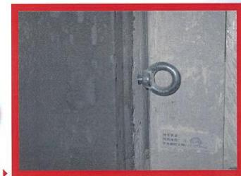
► 沒有將有眼螺栓的螺栓部份完全旋入套筒
