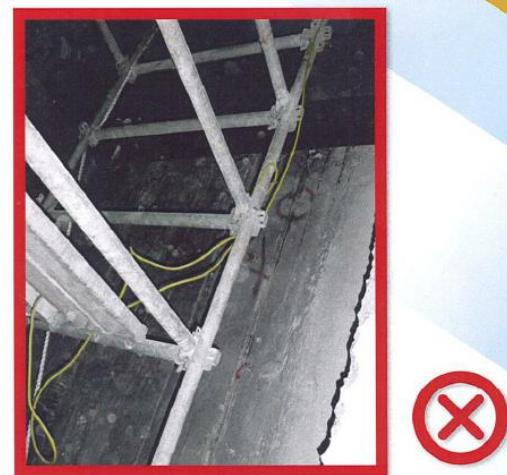
▲ 沒有妥善安放金屬棚架接地導線及使用過長的接地導線
