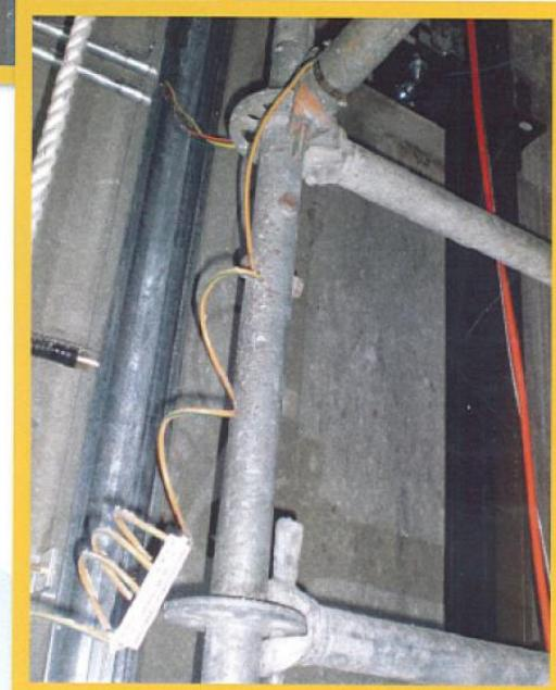
▲ 為金屬棚架穩妥地接上接地導線
