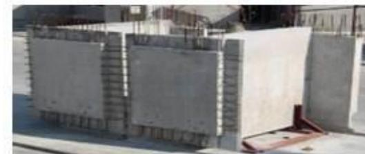
探討使用預製結構牆、升降機槽、組裝建築
