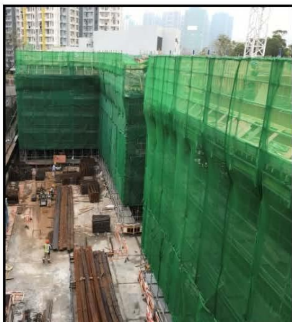
金屬棚架每星期由合資格人仕檢查，及每天由6個合資格技工維修
