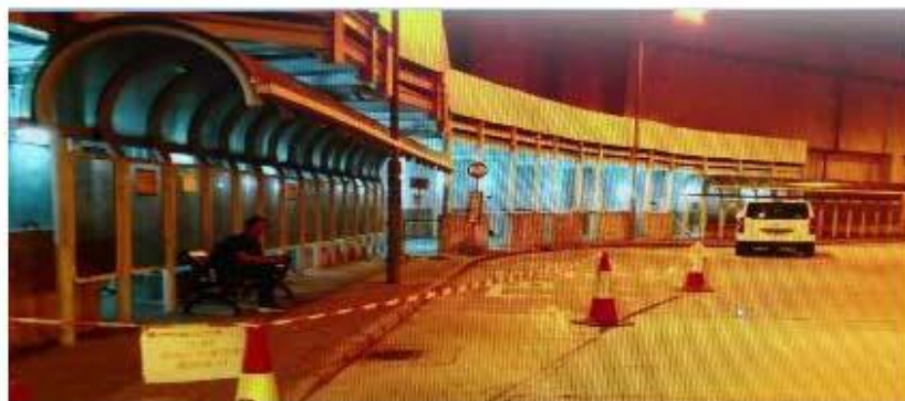
為康城站A出口提供圍街照明
