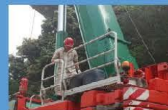
起重機械每月由公司機械部檢查
