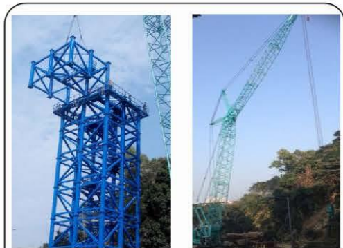
吊運 - 運送臨時及永久結構材料
