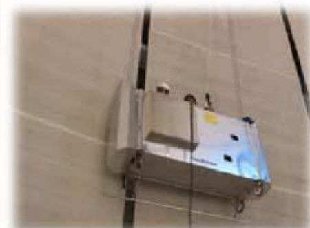
安裝符合地形位置之室內吊船加強高空工作安全
