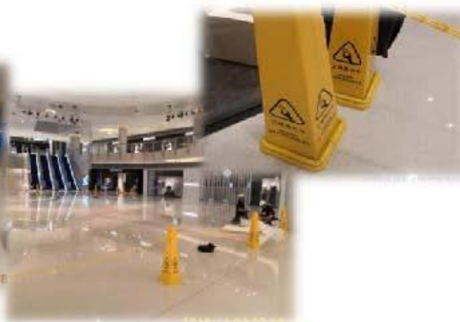
提供應急設備及工地之圍封
