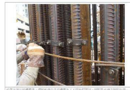
如果吊籠吊起後，便開始進行各組鐵籠加工及打緊螺絲，使鐵籠更穩定及牢固。
