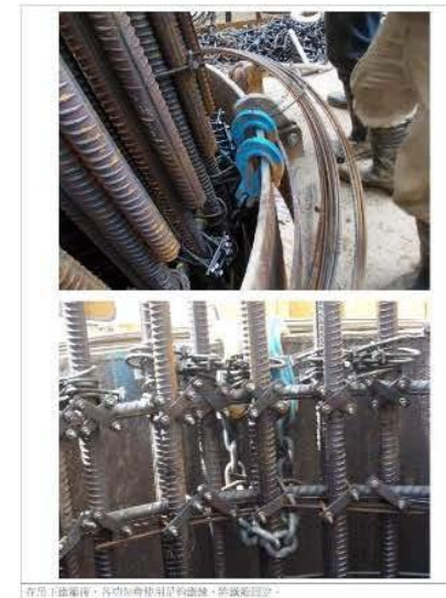
在吊籠吊起後，再作加會鬆可吊的鎖鍊，吊籠和穩定。
