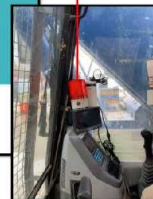
安裝於挖掘機械內的閃燈及響鬧裝置
