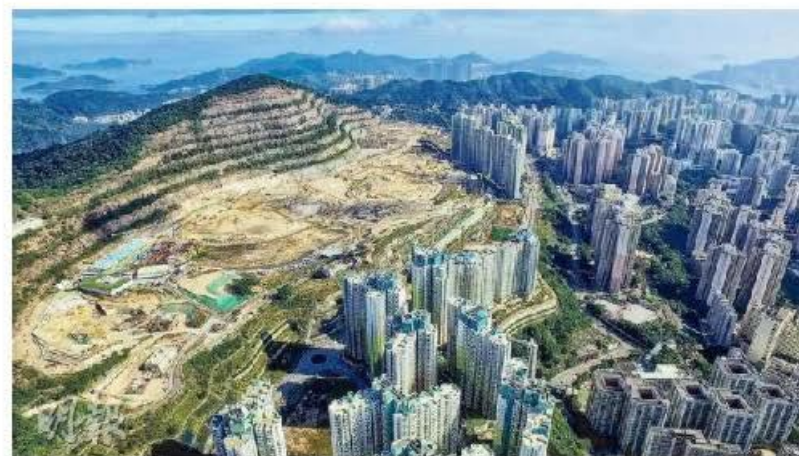
左：房委會計劃在藍田項目採「組裝合成」建造公屋。右：藍田安達臣3公屋項目採「組裝合成」建造公屋。 (資料圖片)
