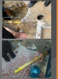
個案 (十八) 進行挖掘工程時擊中地底煤氣設施
