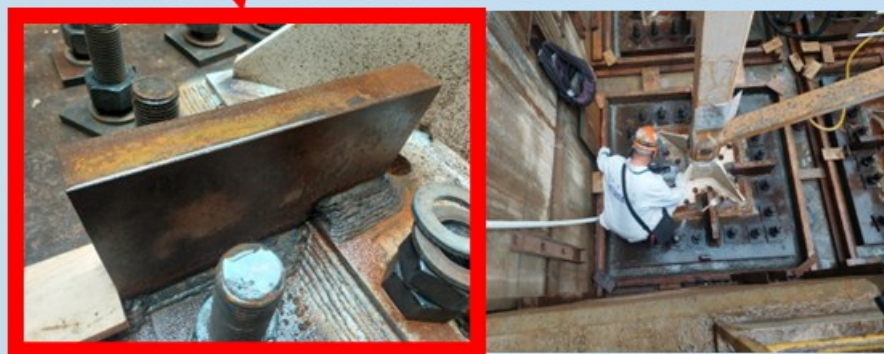
安裝補強板(Stiffener) 為天秤底座提供額外穩定性
