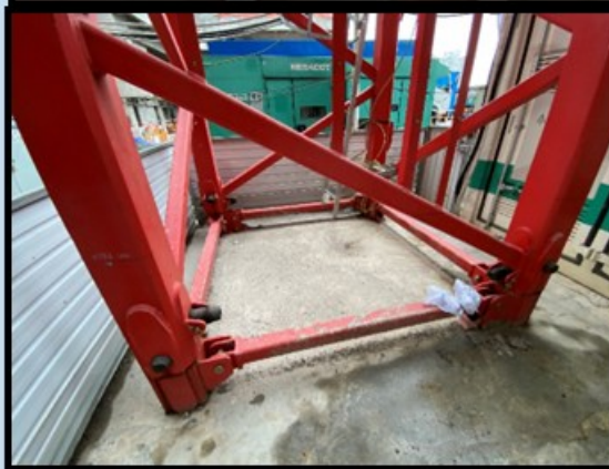
把天秤底座澆注於樁帽(Pile Cap)
