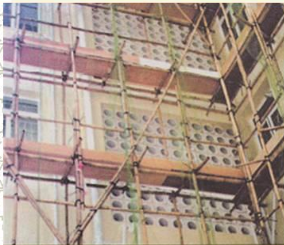
竹棚應為雙行構造(雙棚)以提供適當的工作平台
