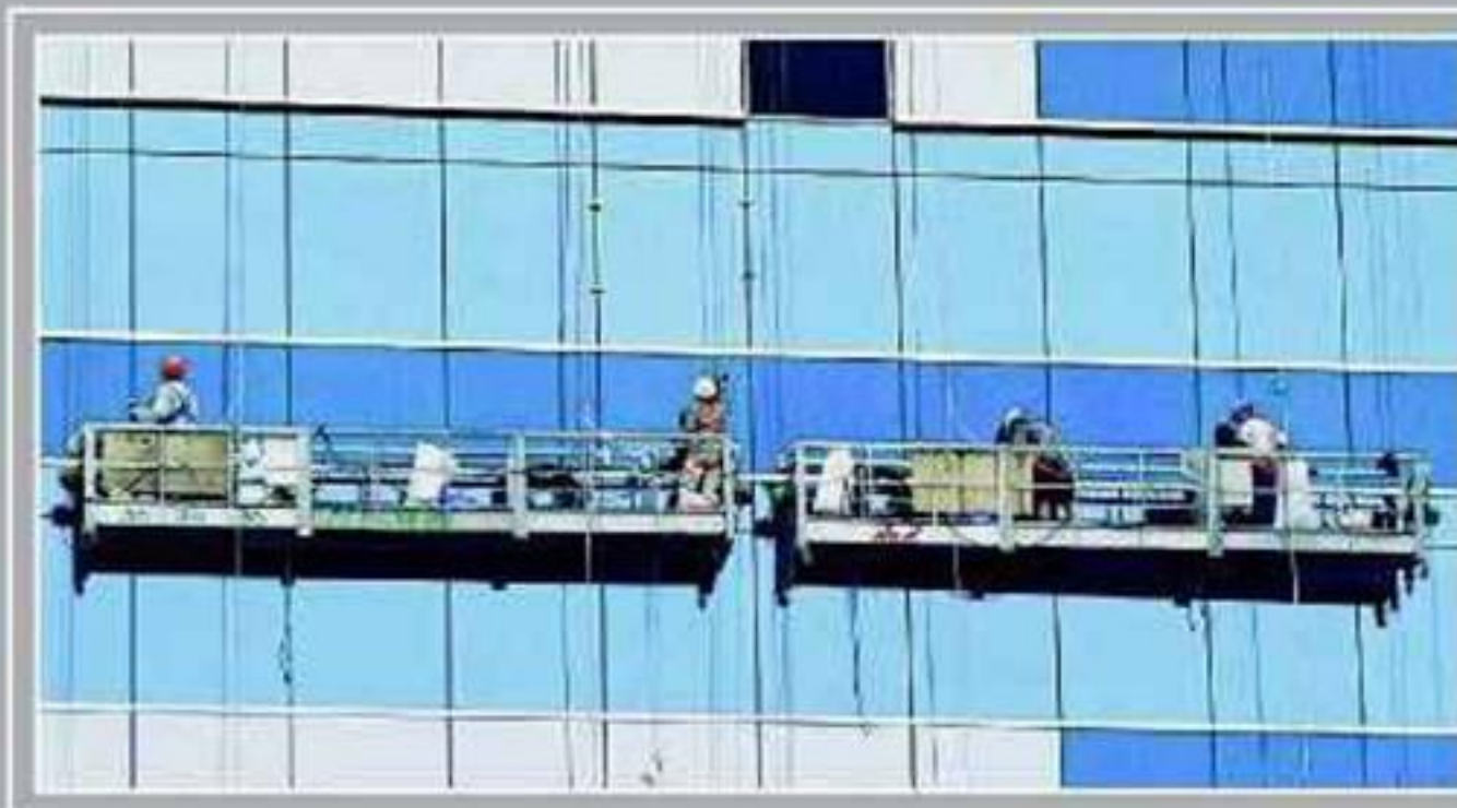
吊船在外牆進行 維修/清潔
