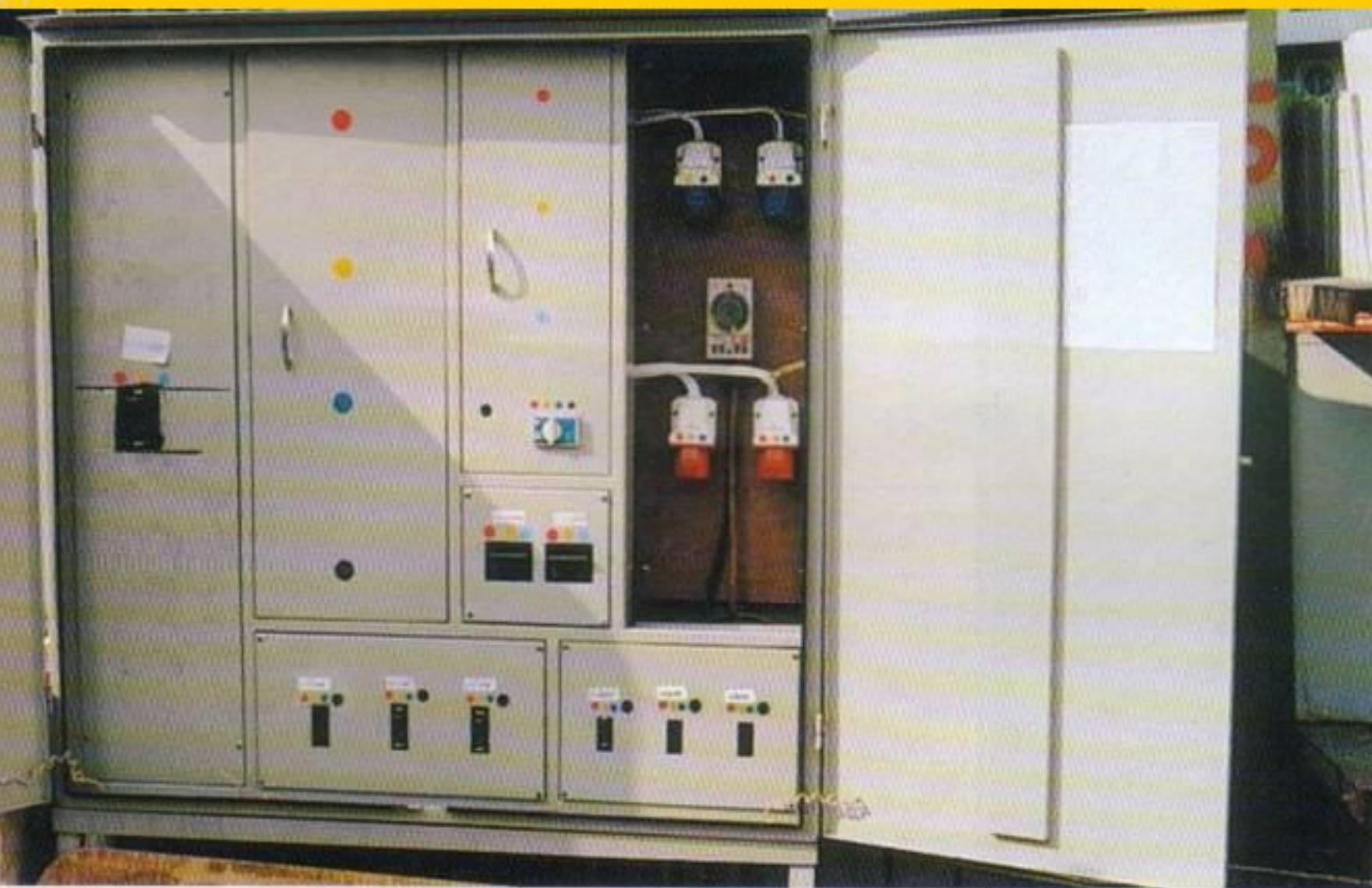
設有漏電斷路器、電路圖和每個開關掣有清楚標示的總電掣箱
