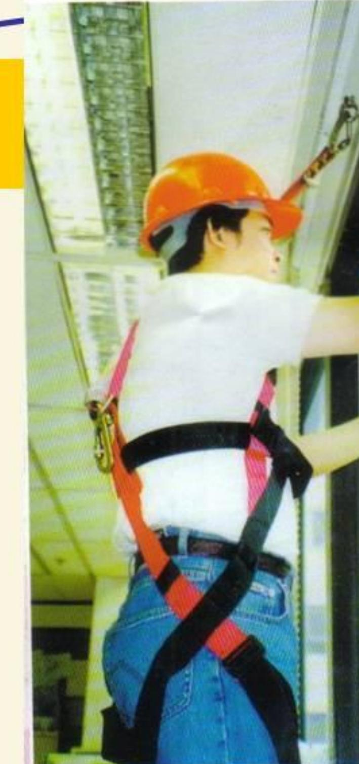
防止工人由高處墮下的個人裝置，包括全身式吊帶和固穩物（在任何情況應先考慮適當工作台）
