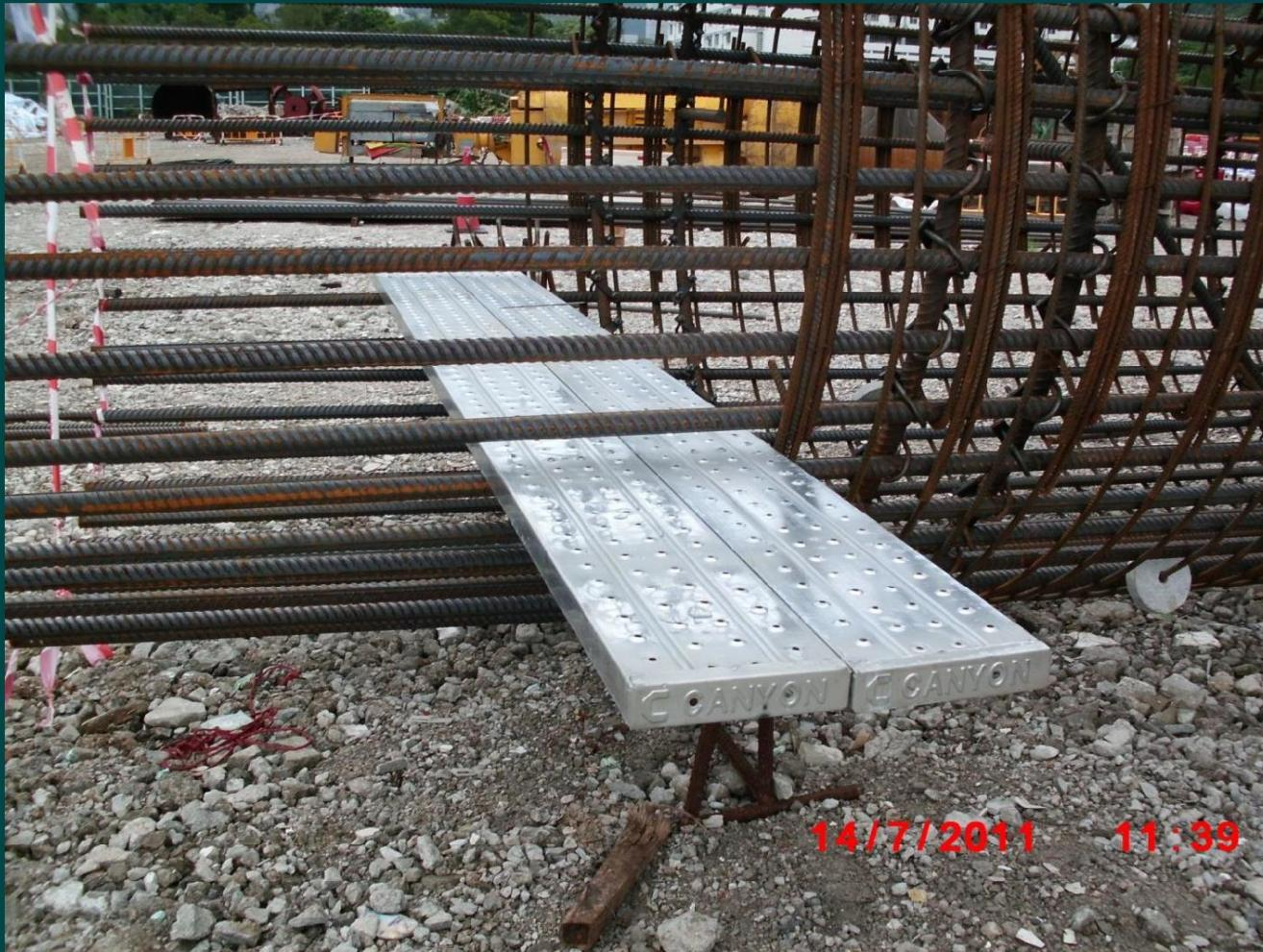
橋板是否穩固給工人站立工作及承托鋼筋
