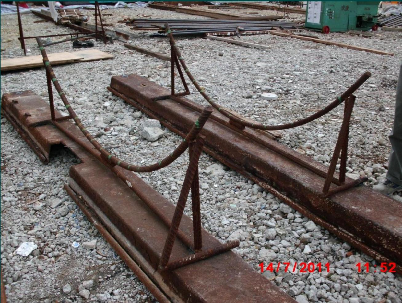
穩固鐵籠的弧形結構支架
