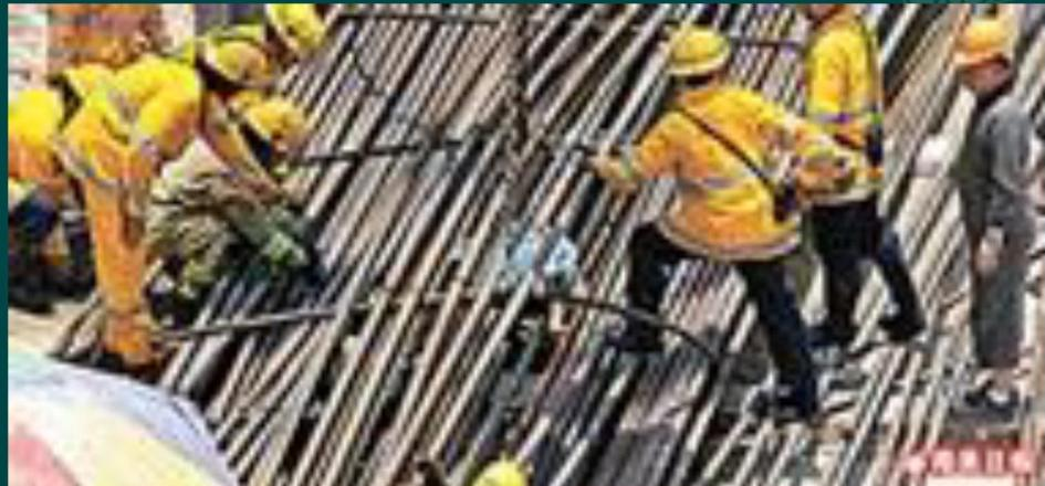
荃灣一個建屋地盤發生工業意外，作沉箱用的圓筒形鐵籠忽然散開倒塌，消防員撐開鋼筋搶救被壓工人。
