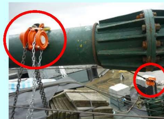
在臂身兩側,各加設一個駁洛收緊固定吊杆
