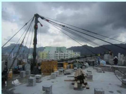
事故現場~第二座天面躉船式吊杆
