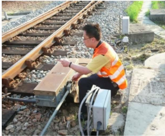
確認轉換路軌分叉口 方向正確
