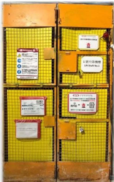
已安裝RFID管理系統之升降機槽
