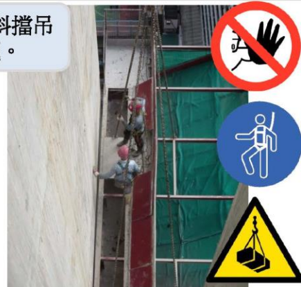
步驟2：再將掛斜擋爬升，最後裝回外牆掛籠
