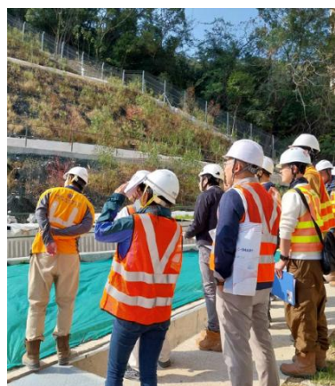
房委会与土拓署同事联合检查施工的斜坡。
