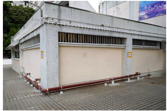
启业社区会堂公用厕所于屋邨公用地方增建独立排污系统。
