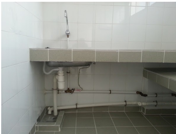
(b) 單位內：以壓合接頭方式接駁的銅喉
