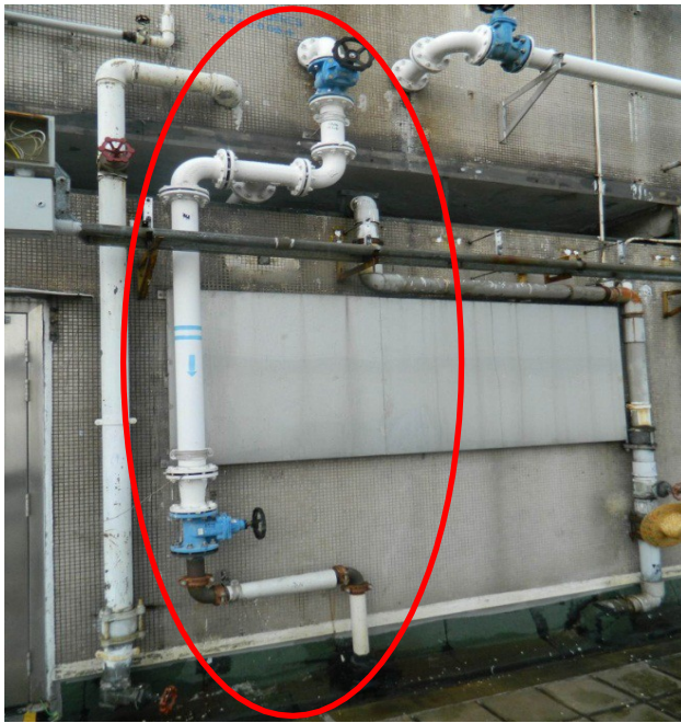
圖1：以凸緣接頭方式接駁的延性鐵管，由水缸連接到銅製配水管
