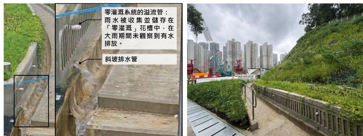
零灌溉系統在紅色暴雨警告信號期間（左）和黑色暴雨警告信號後，仍然運作良好。
