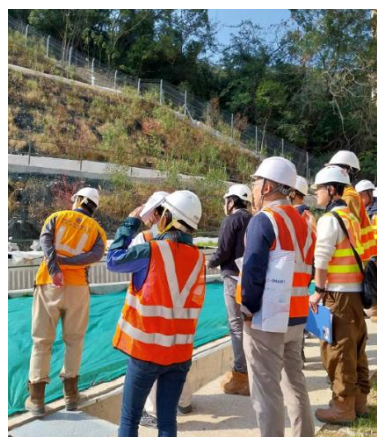
房委會與土拓署同事聯合檢查施工的斜坡。
