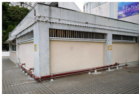
啟業社區會堂公用廁所於屋邨公用地方增建獨立排污系統。
