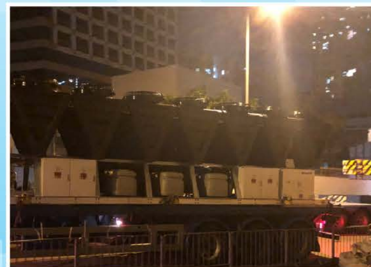
新五號冷凍機到達現場
