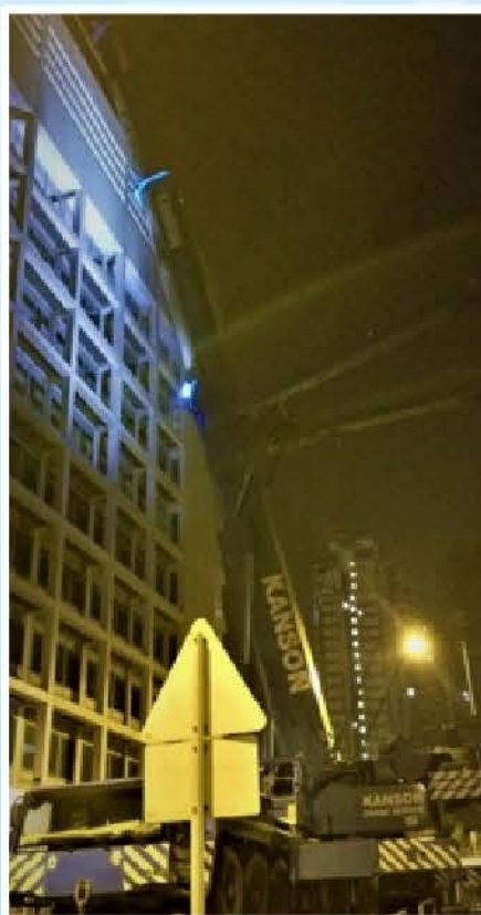
黑夜中巨型吊臂車在狹窄的牧愛街進行吊運
