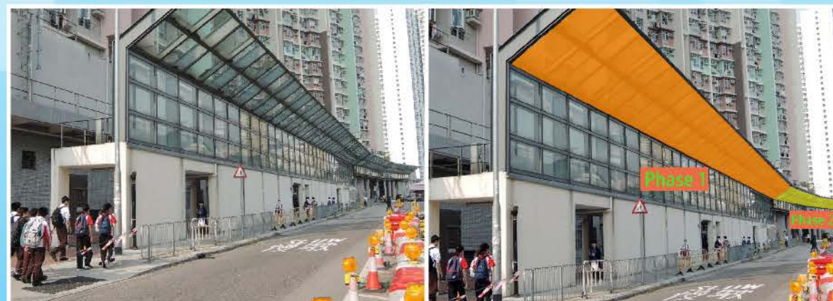
隔音屏玻璃面板原貌
