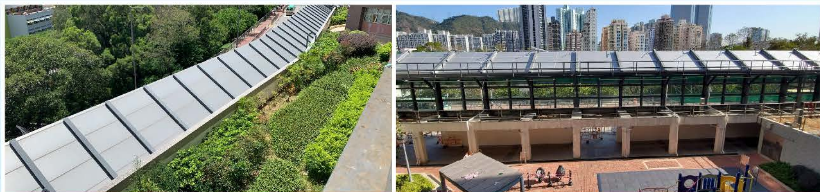
優化後的隔音屏，物料耐用耐燃，且容易維修及清理，工人可在其上安全工作，排水系統可防止滲漏，結構承重獲得減輕，隔音效果良好。
