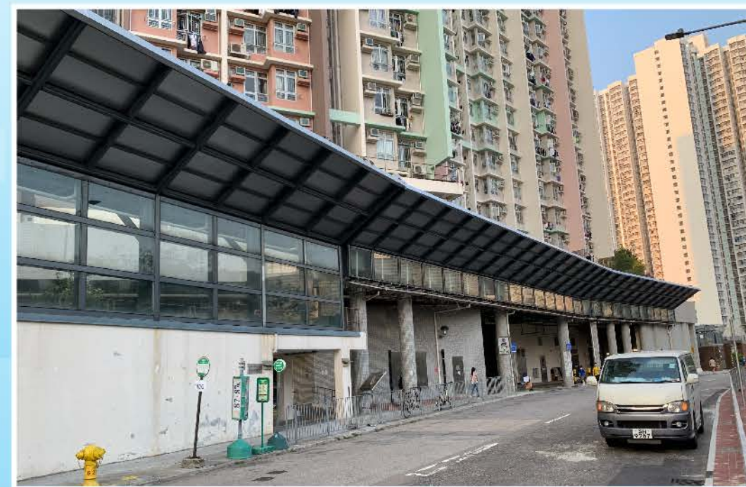
工程完成後照片
