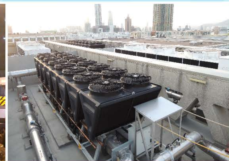
新安裝的三號和五號冷凍機
